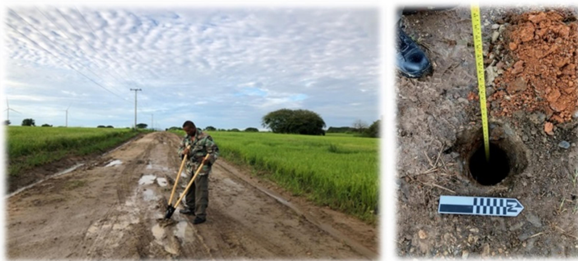
Fotografía 21 Excavación de pozos de sondeos sobre el trazado de la calle
