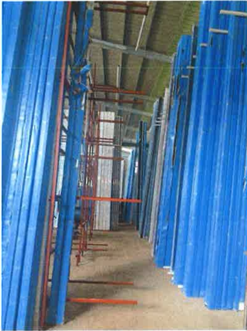
Foto N°2: Se procederá con la descarga del Contenedor y la separación por medidas de los marcos de ventadas
