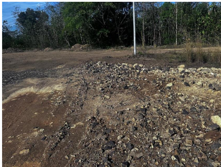
Ilustración 4 Vista del sitio. Fuente: Equipo Consultor
