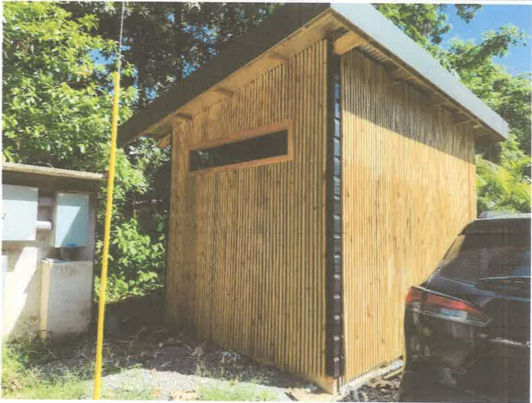
Figura 11. Vista del proyecto, bodega de 2.5mx3m que alberga el genrador eléctrico.
