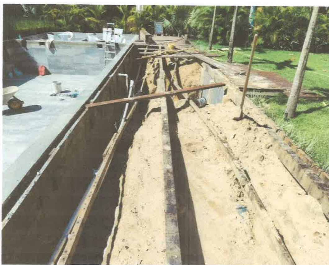
Figura 10. Vista del proyecto, observamos el suelo arenoso. Reparación de tuberías y mantenimiento
