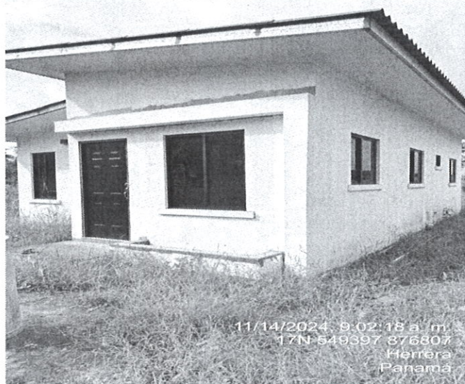
Foto No. 3: Se observó una casa construida en fase de acabados. Durante la inspección no se observó personal laborando en el área.
