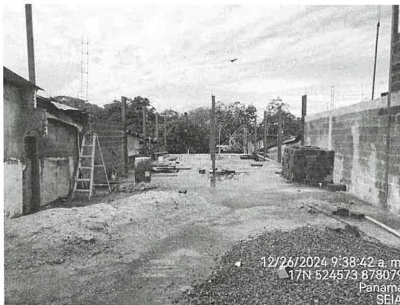
Foto 2. Otra vista del área del proyecto, se observa columnas de viga H y tubo cuadrado y materiales entre estos: arena y piedra.
