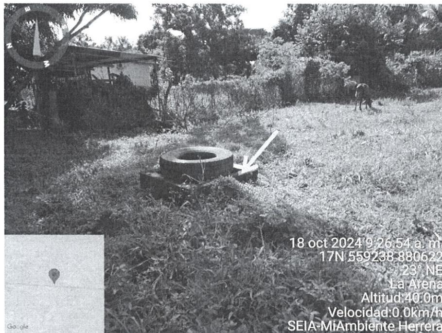
**Fig. No. 4:** Tragante pluvial (el cual no mantenía tapa), ubicado en el área del proyecto.
