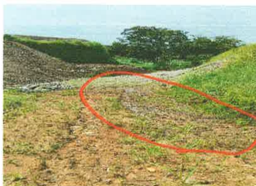
Se observa filtración de agua
