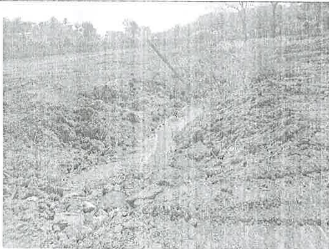
Foto 12. talud originado por el movimiento de tierra y nivelación realizado para la construcción de la galera
