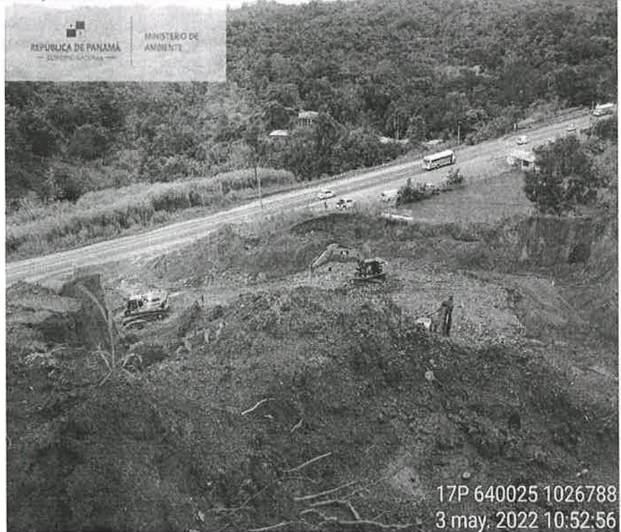
Foto 10. Vista de la pendiente existente por extracción de material pétreo próximas a las estructuras existentes
