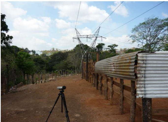
Foto N° 12 Toma de dato en la torre 34 de Elektra en Calzada Larga.
