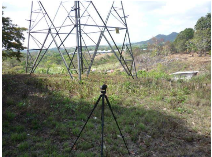
Foto N° 10 Medición en la torre 24 de Elektra, por la calle Arco Iris.
