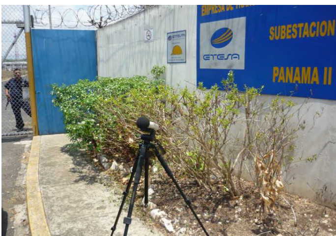
Foto N° 16 Medición al frente de la subestación Panamá II.
