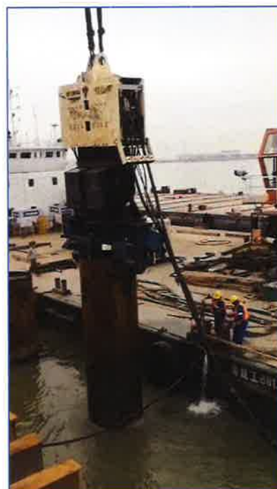
Figura 1-6. Remoción de pilotes con vibro martillo
