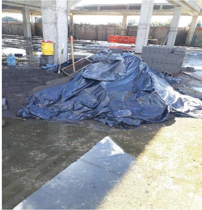
Anexo 3. Medidas de control de sedimentos.
