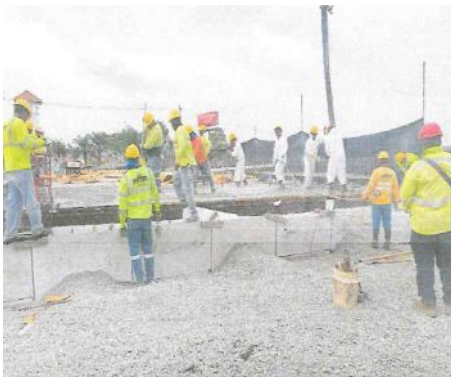
Vaciado de concreto para construcción de losa.
