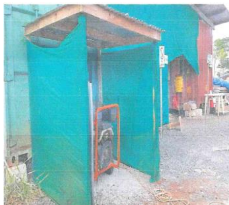
Galeras con tinas de contención para equipo con hidrocarburos.
