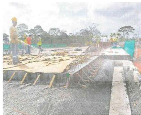
Colocación de losas de concreto del puente.
