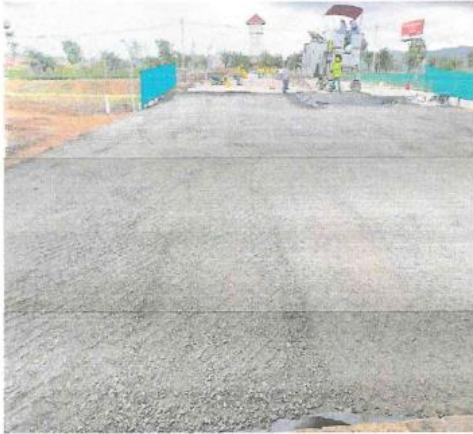
Conformación de los accesos al puente
