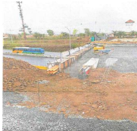
Encofrado de concreto para construcción de losa.
