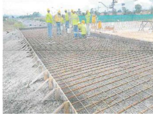
Amarre del acero para construcción de losa del puente.
