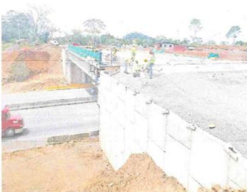
Construcción de acceso al puente con muros de tierra armada.
