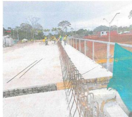
Construcción de jersey y veredas peatonales
