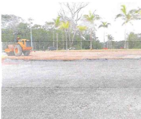
Conformación de pista de acceso al puente.
