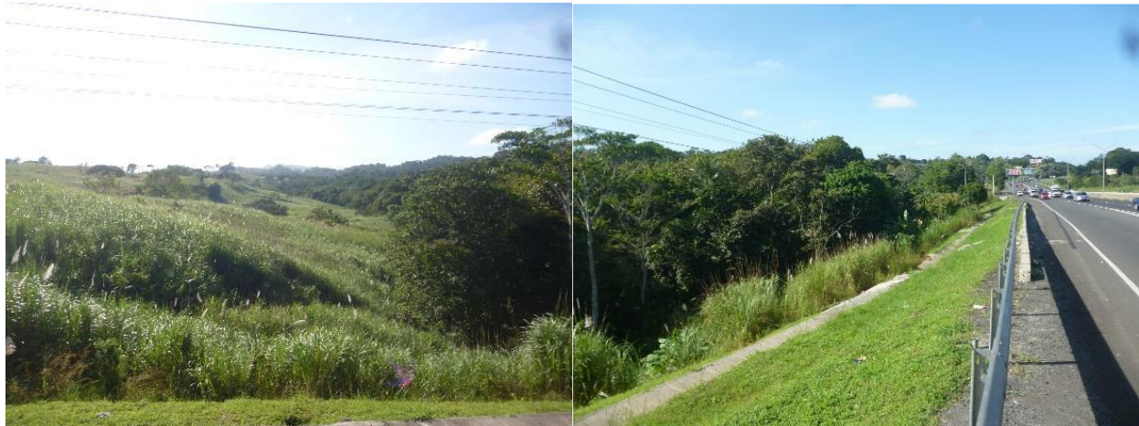
Foto 1: Fotos Ubicación PTAR Alternativa 1
