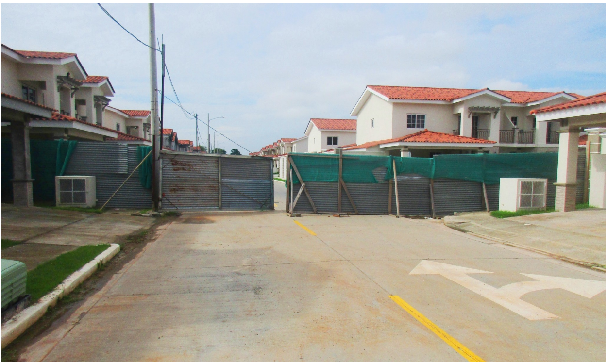
Fotografía 29 Áreas de construcción segregadas de aquellas habitadas mediante mamparas
