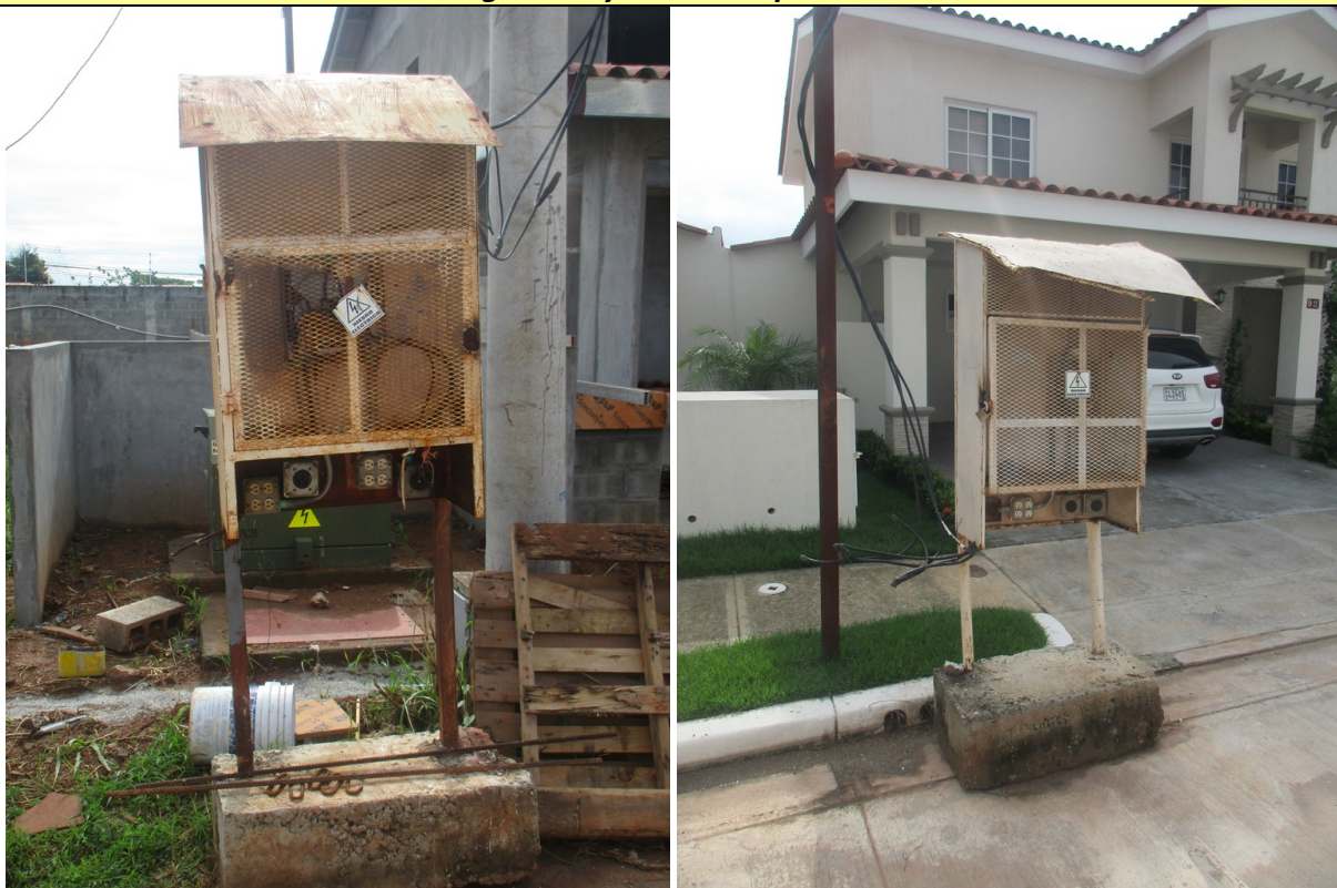
Fotografía 24 Instalaciones eléctricas, protegidas de la lluvia, con letrero de advertencia por riesgos eléctrico y tomacorrientes para distintos voltajes
