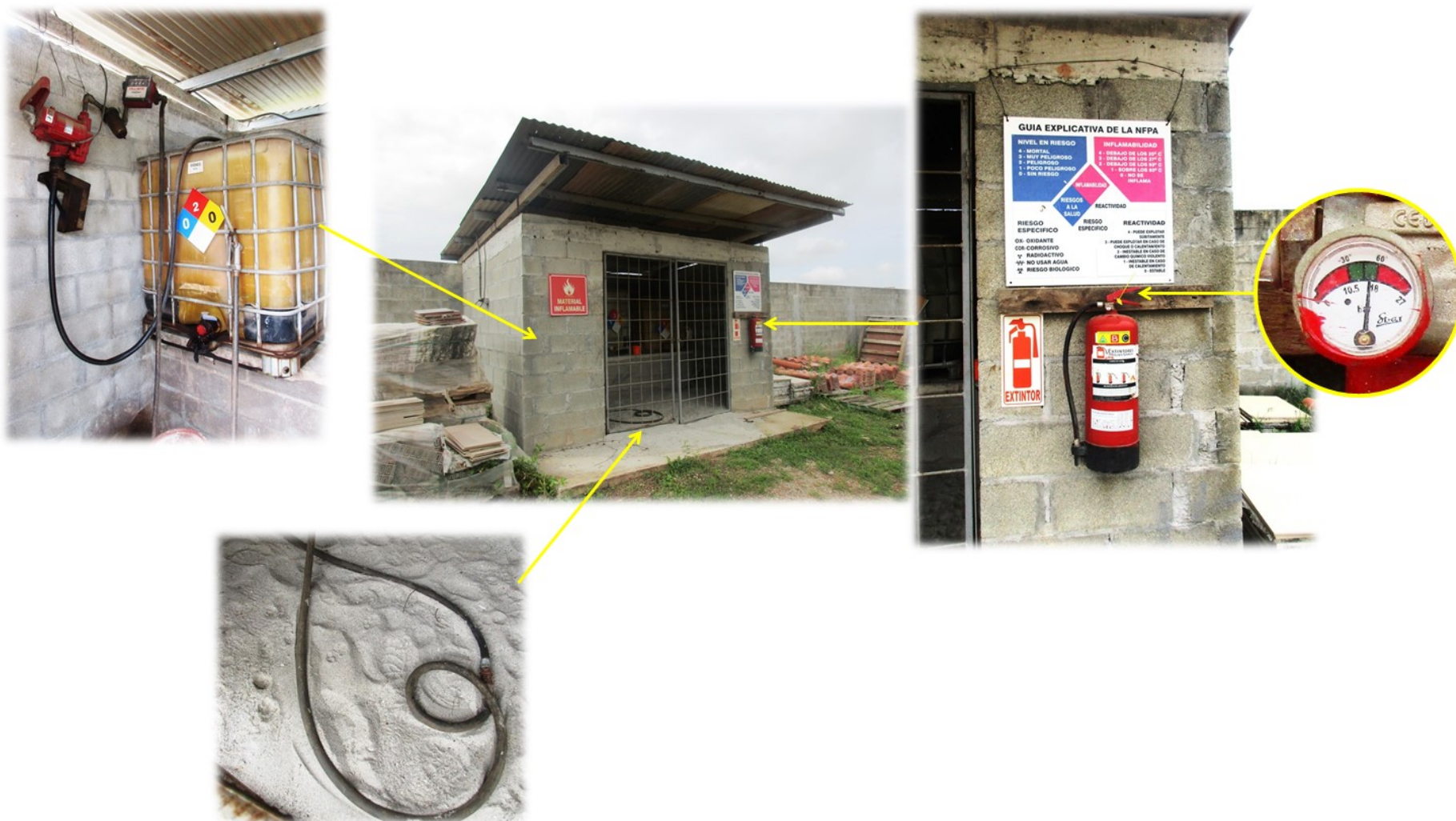
Fotografía 23 Caseta de combustibles de bloques, techada, con buena aireación, diamante NFPA en cada recipiente, letrero de advertencia y extintor cargado; se cuenta con una bomba Fill Rite con su medidor y hay arena en el suelo para absorber goteos de combustible
