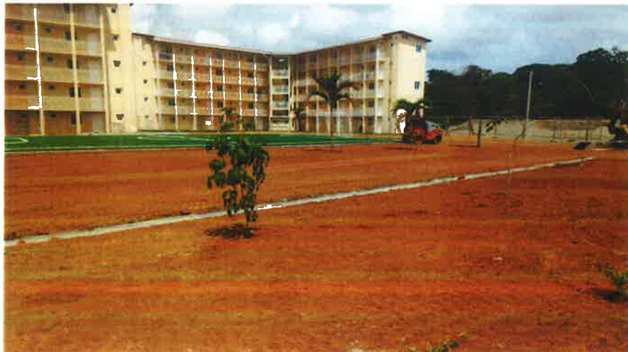
Fig. 3. Utilización de material arcillas, para relleno de áreas que lo ameriten en el proyecto de Renovación Urbana de Colón
