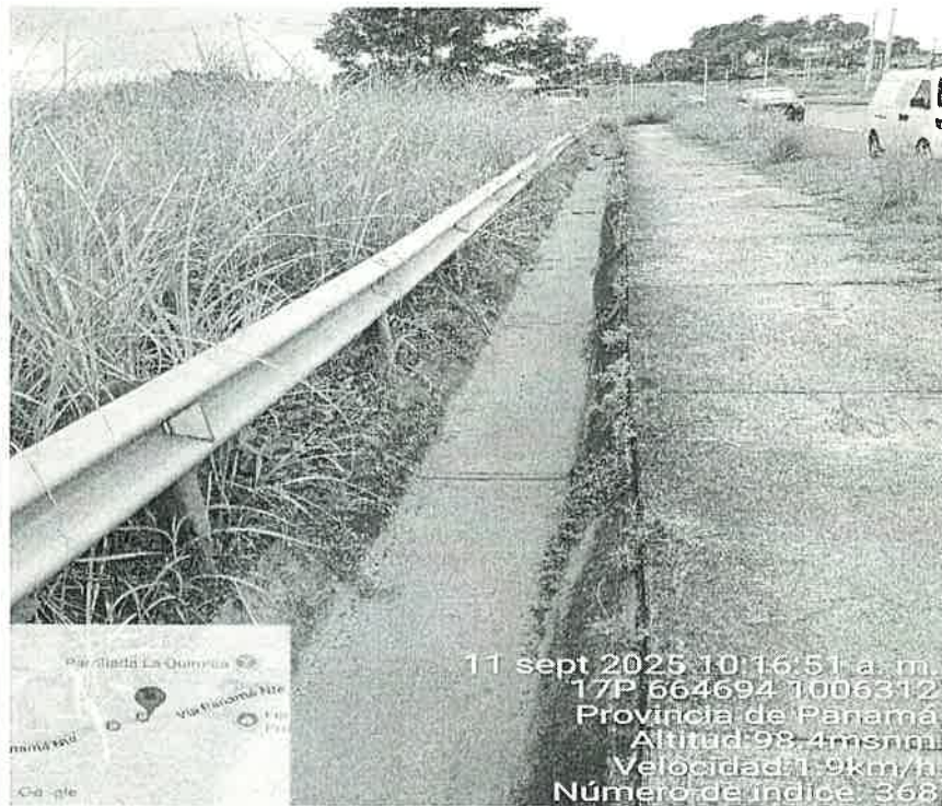
Imagen # 3. Vista del sitio del alineamiento de la infraestructura para la descarga de las aguas residuales.
