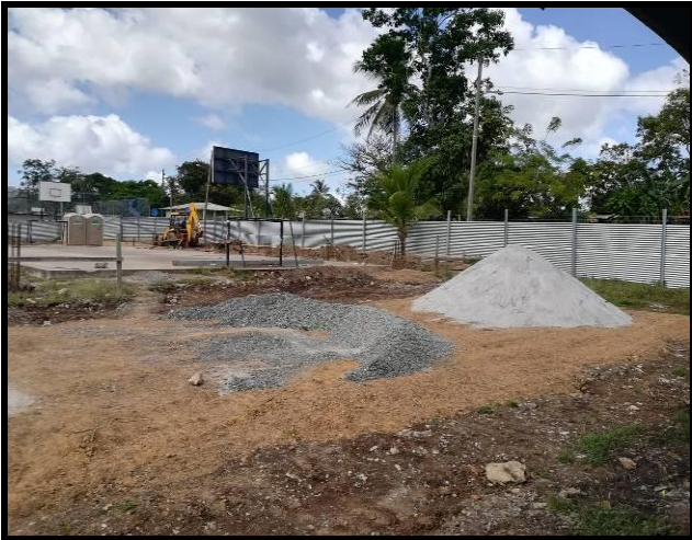
Fotografía No. 2: Foto que muestra el almacenamiento de los materiales agregados. Tomada en marzo 2019.
