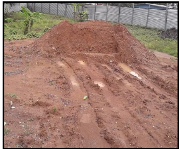
Fotografía No. 7: Foto que muestra que el material producto de las excavaciones en ciertas ocasiones es reutilizado dentro de la misma obra. Tomada en marzo 2019.
