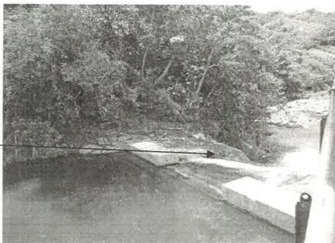
Foto N° 3. Desvio del caudal del Río Chico.
