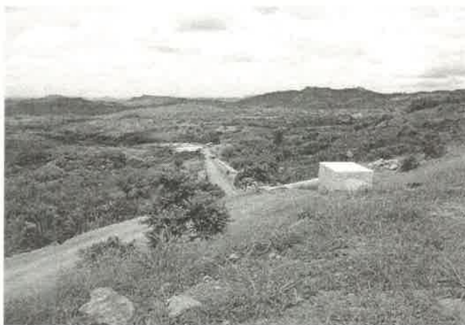
Foto N° 5. Vista general de la tubería que conduce el agua hacia la casa máquina.
