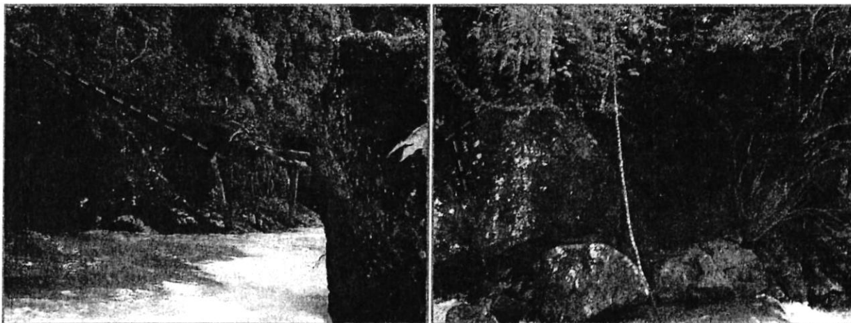
Fotos 11 y 12. Rocas fracturadas sin desplazamiento en los taludes del río Chico [G. Torres, 09/05].
