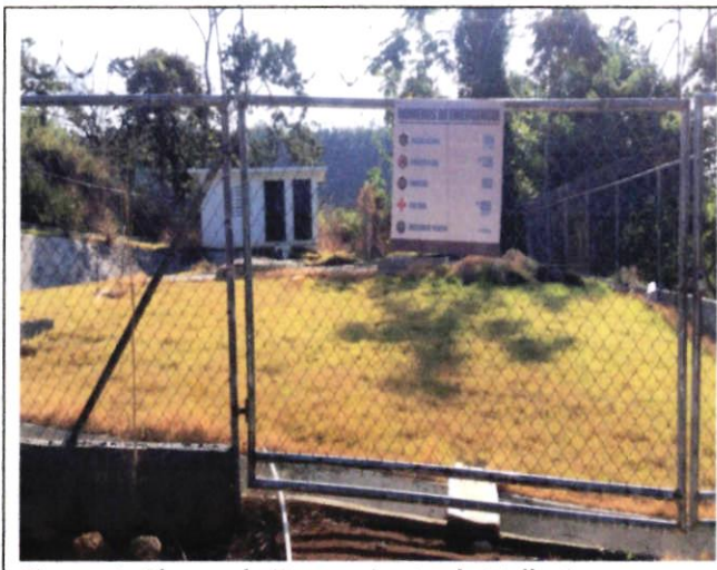
Figura 1. Planta de Tratamiento de Valle 6
