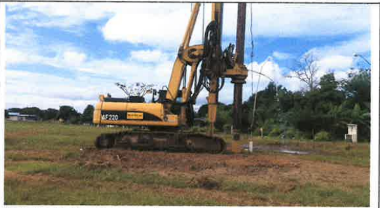
Figura 2. Prueba para los pozos en los terrenos donde se pretende desarrollará el proyecto.
