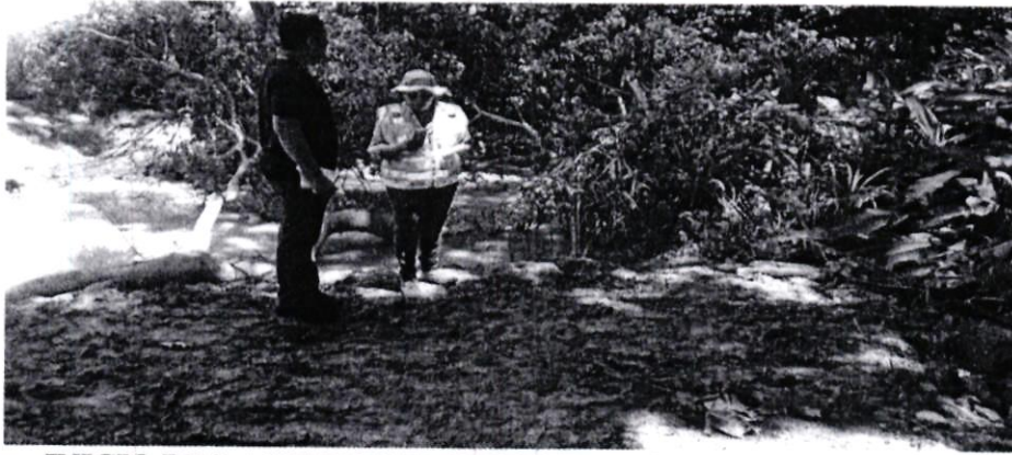
INICIO DE LA DE DESVIACION DE LA QUEBRADA
