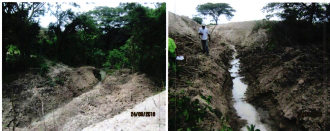
Imágenes 7 y 8. Vistas del área próximo al Río Hato, después de los trabajos del desvío de la quebrada
