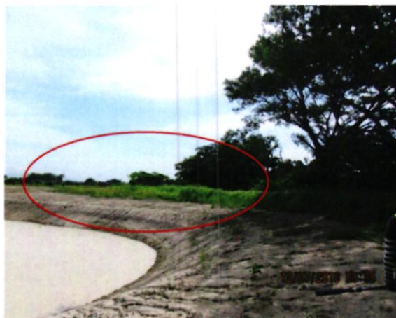
Imagen 11. Vegetación herbácea la primera parte del desvío antes de los trabajos
