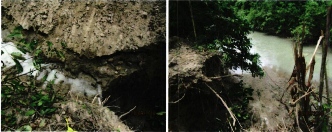
Imágenes 26 a 27. Tramo final del nuevo Cauce de la Quebrada Aguas Blancas (Aguas Claras) y su descarga al Río Hato
