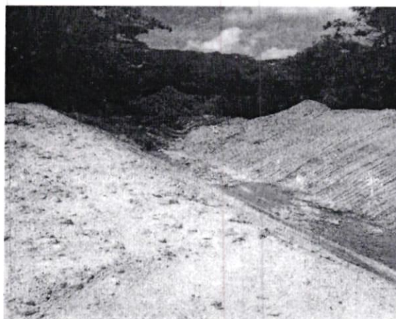
Punto de descarga que llevará el exceso de agua que va del lago hacia Río Hato
