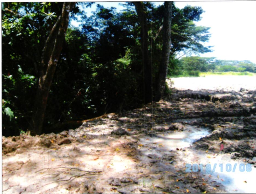
Foto. N°1 Unión a quebrada Agua Clara e inicio del Canal artificial
