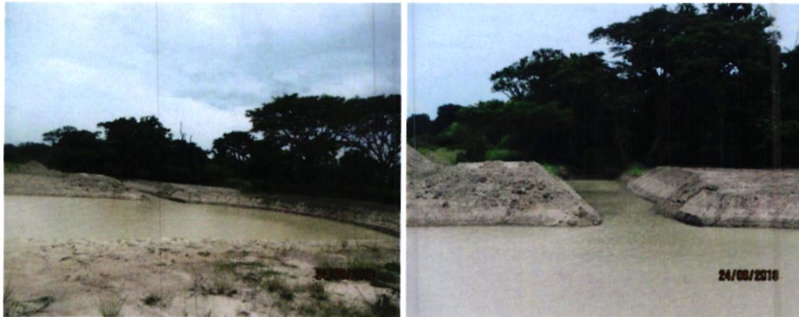
Imágenes 16 y 17. Vista del lago y cauce creado para el desvío de la Quebrada Aguas Blancas (Aguas Claras)
