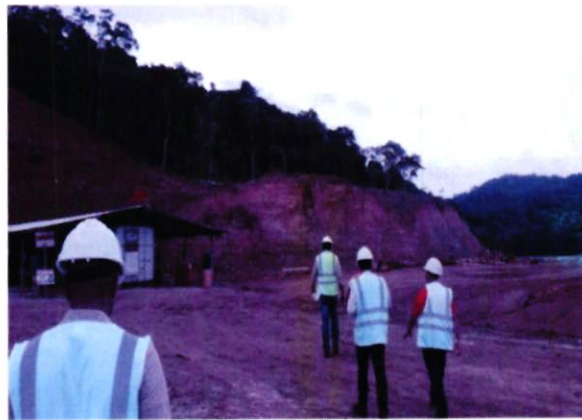
Foto N° 4. Viste de taludes sin estabilizar.
