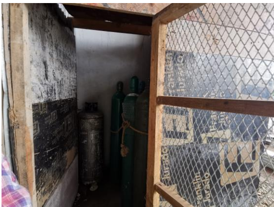
Foto 19) Recinto de resguardo de gases comprimidos
