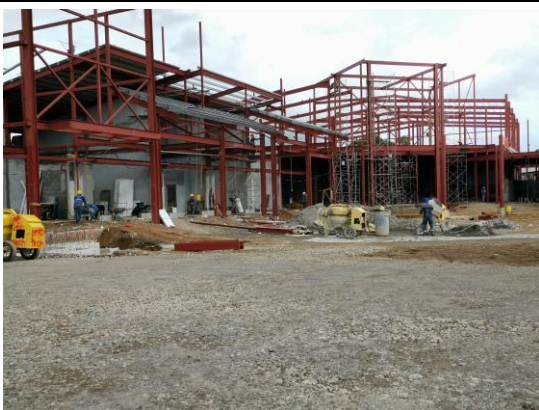
Foto 5) Trabajos de construcción de columnas
