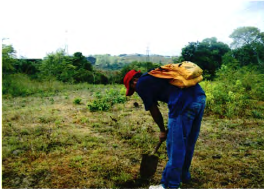
Foto N°.2. Sitio de construcción de torre 7.
