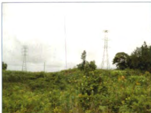
Se puede apreciar el área donde se instalará la torre T 25 en Santa Rita Arriba, con la primera fase del proyecto ya instalada
