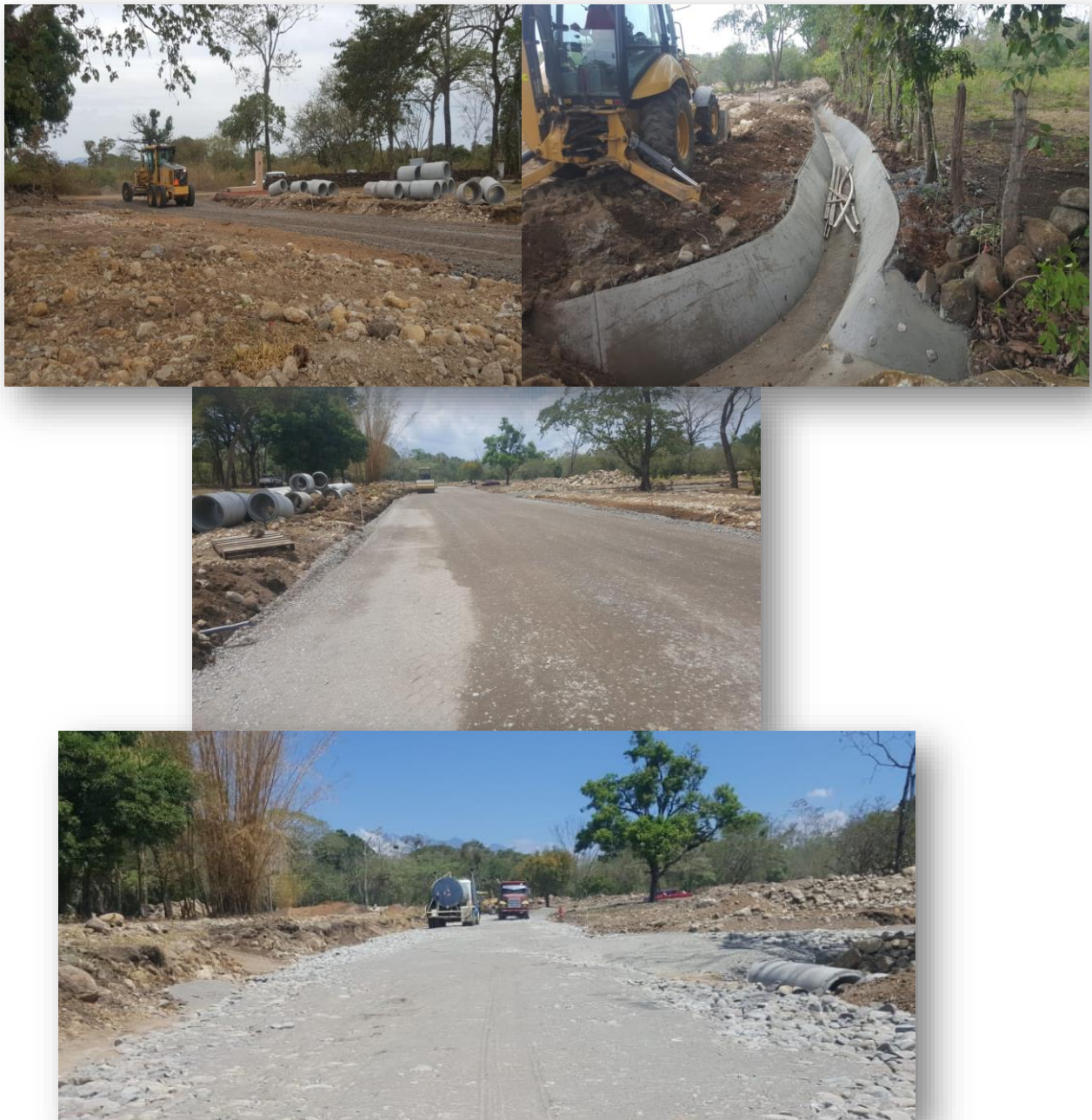
Fotos 3,4,5 y 6. Inicio de construcción de calles se observa el equipo pesado utilizado, construcción de drenajes al fondo la cisterna para control de polvo y los trabajadores del contratista portando el EPP. - Archivos de la empresa
