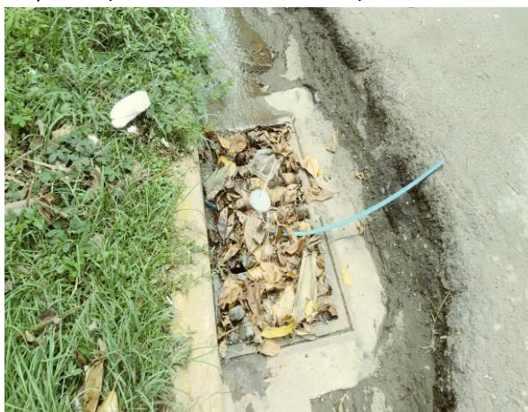
Foto 15. Drenaje pluvial obstruido.
