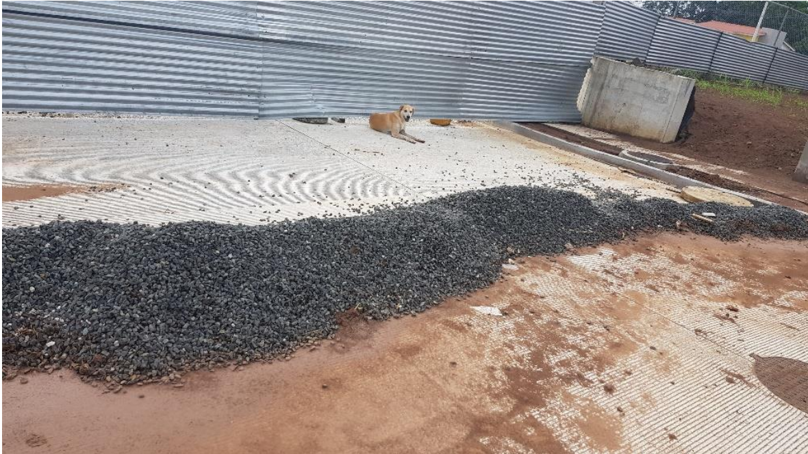
Foto 7. Proyecto Santillana. Barreras para controles internos de erosión y sedimentación
