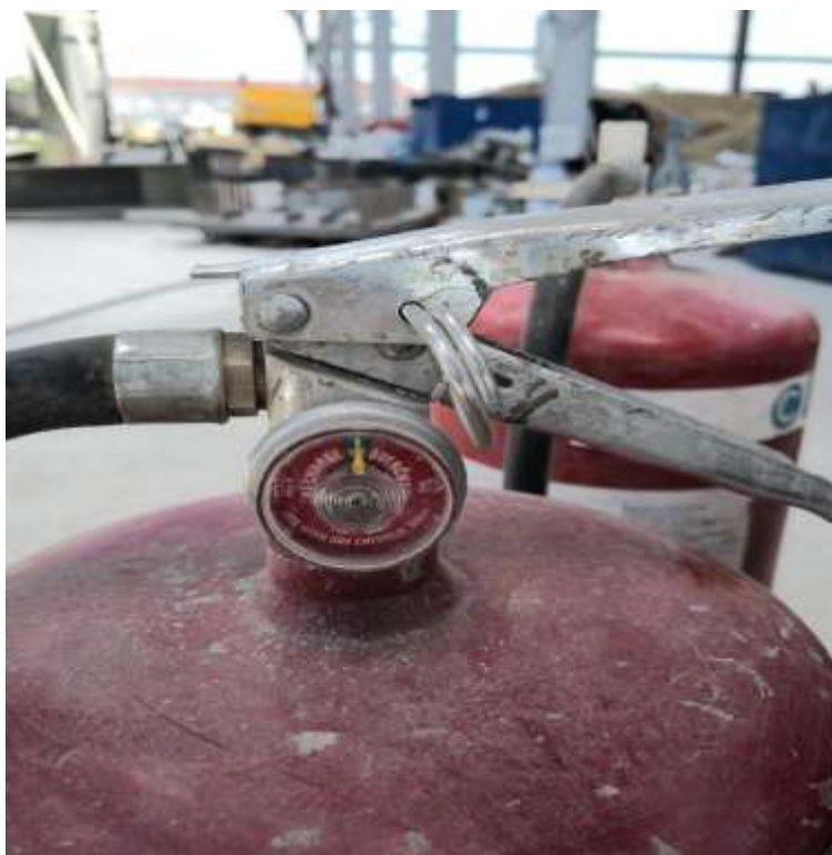
Ilustración 10 Extintores con el Nivel de Presión Requerida
