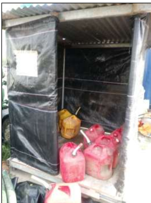
Fotografía No.8 y 9: Lugar de almacenamiento de combustible con su noria de contención
