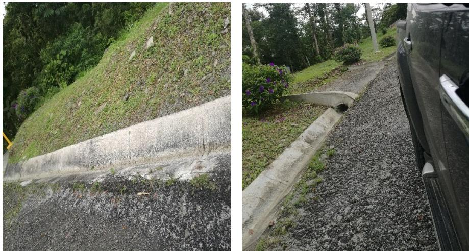
Foto 7-8. Vista de algunas de los drenajes, los cuales están conformados con concreto.
