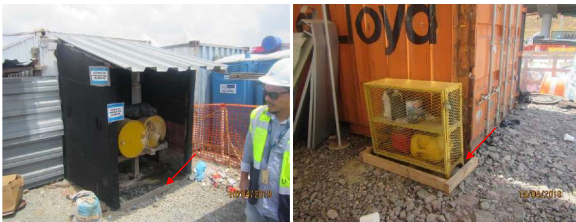
Imágenes 59 y 60. Sistema de contención inadecuado, en el área de P&T y la Estación Nuevo Tocumen
