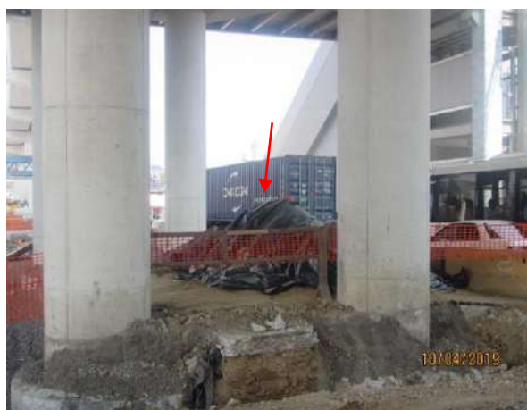
Imagen 34. Suelo producto de la excavación debidamente cubierto con una lona
