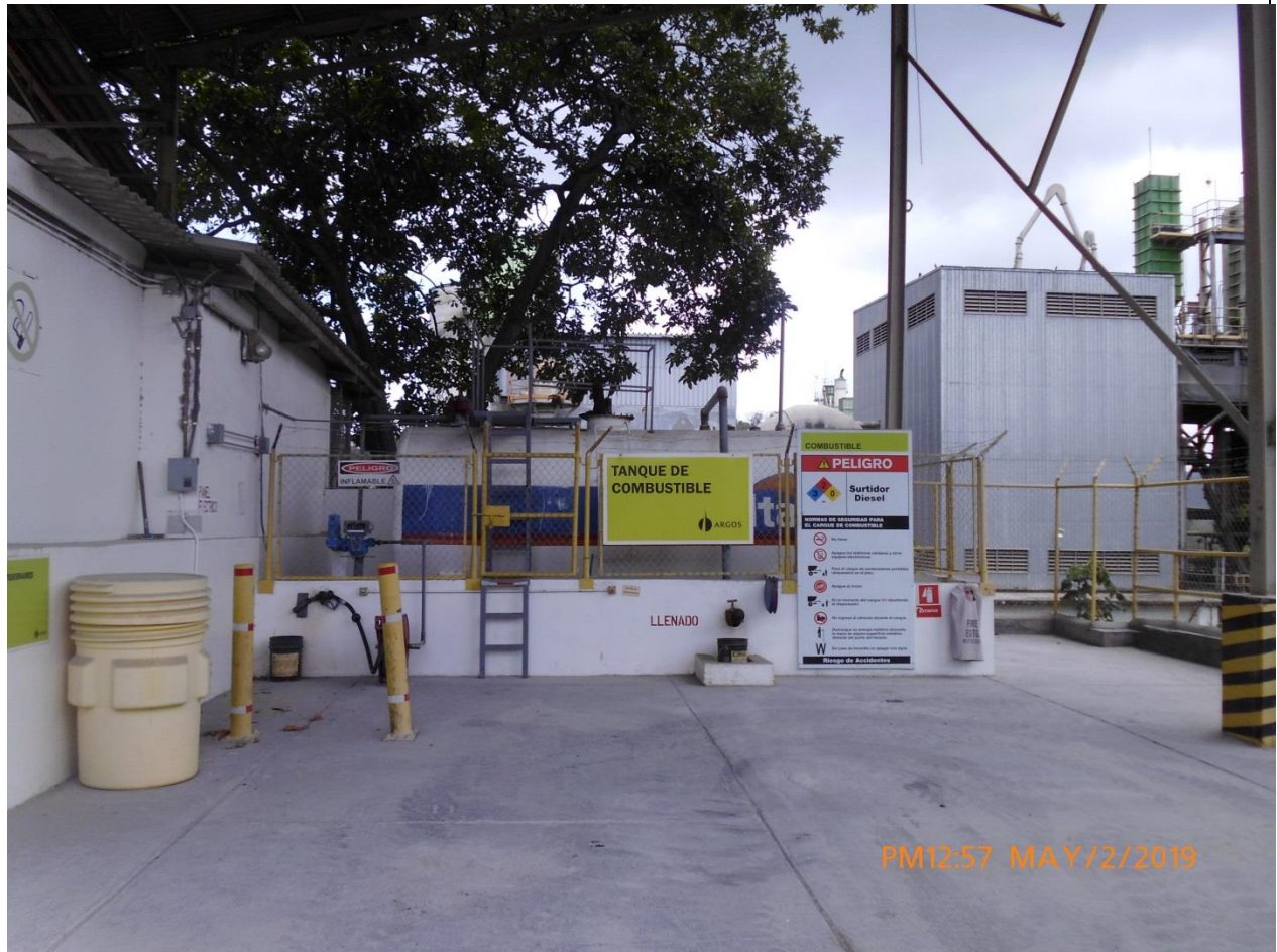
Fotografías No. 1: Área de tanque aéreo de almacenamiento de combustible con contención secundaria, señalización pertinente y kit de derrame. Fuente: Grupo ITS, inspección 2 de mayo de 2019.
