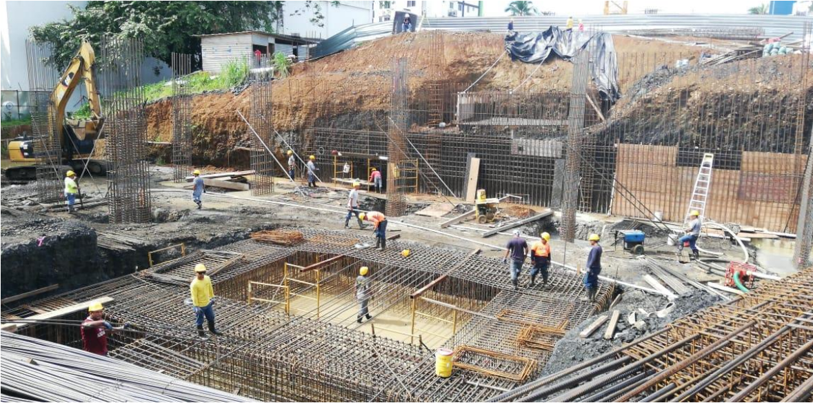
Foto No. 15.1.7: Avance general de construcción de fundaciones tipo zapata. Observar los trabajadores usando EPP.
