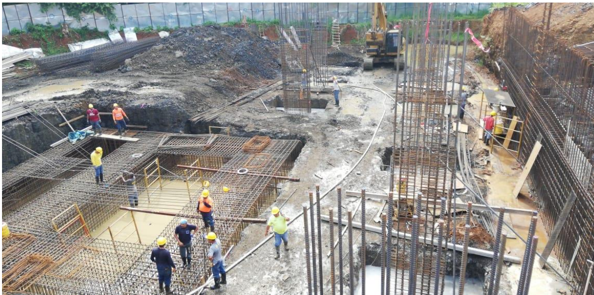
Foto No. 1. Vista panorámica del Avance general de la construcción de las fundaciones, se observa el armado de refuerzo con barra de acero. Observar el grupo de trabajo con sus cascos de seguridad y botas y camisas manga larga.
