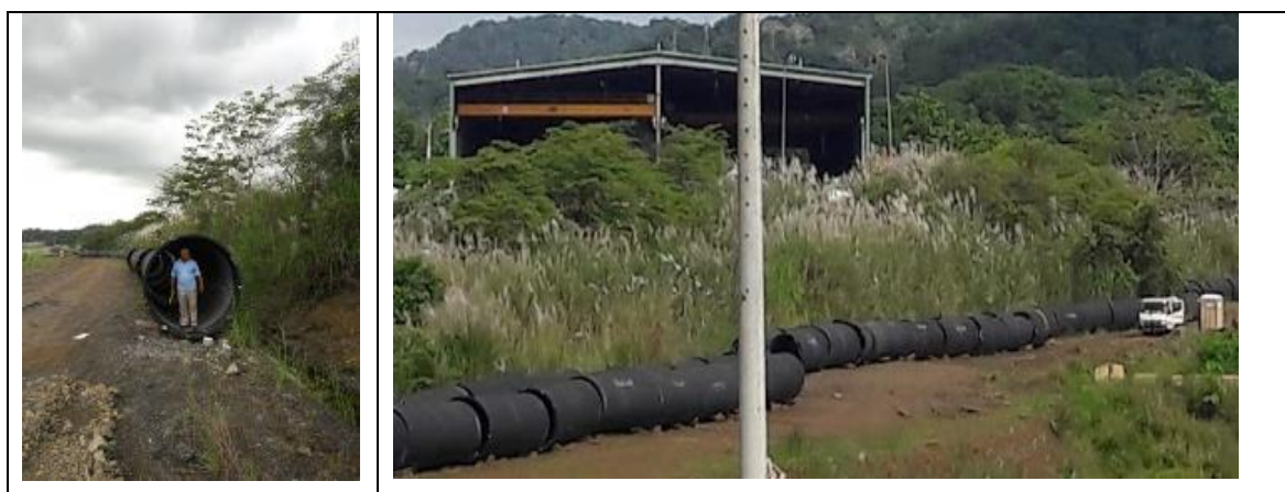
Figuras No 5.12 y 5.13. Vistas de la tubería de 72 pulgadas que abastecerá de agua potable a La Foresta Norte, Clayton, la Ciudad de Saber y varios corregimientos del centro del municipio capital de Panamá. Fuente D. Arauz octubre de 2018.
