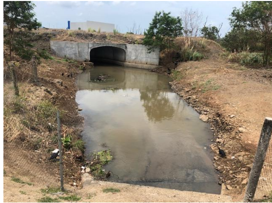
Foto 2. Entubamiento de drenaje aguas abajo
