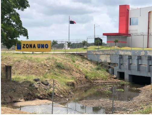
Foto 1. Entubamiento de drenaje aguas arriba
