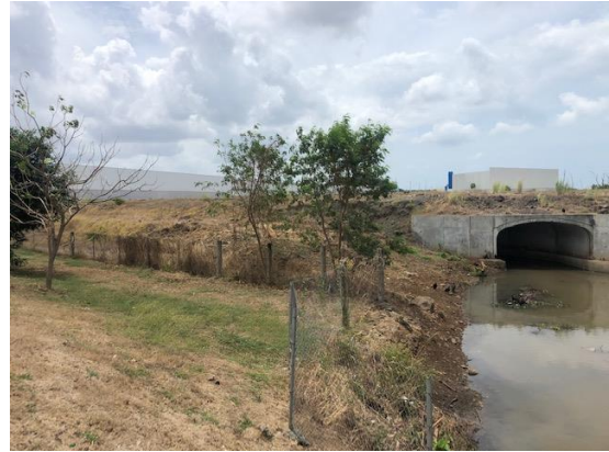
Foto 2. Entubamiento de drenaje aguas abajo
