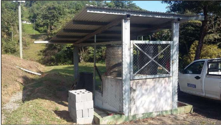
Imagen N°1. Evidencia del sitio donde se tiene la noria de contención para las combustibles e hidrocarburos que se almacenan en la finca para evitar algún tipo de contaminación..
