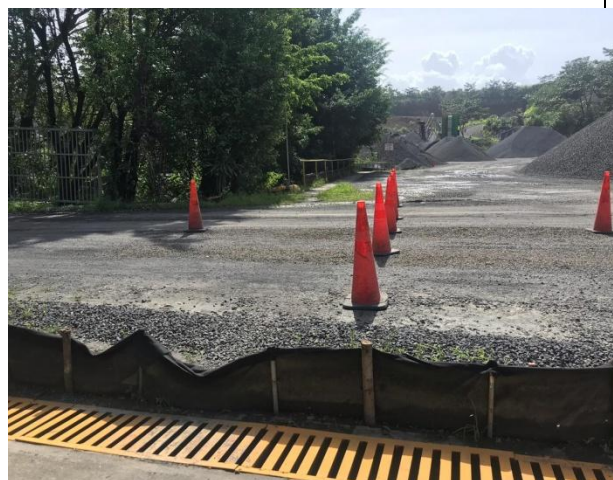
Vistas de la medida de control de erosión existente en el proyecto.
