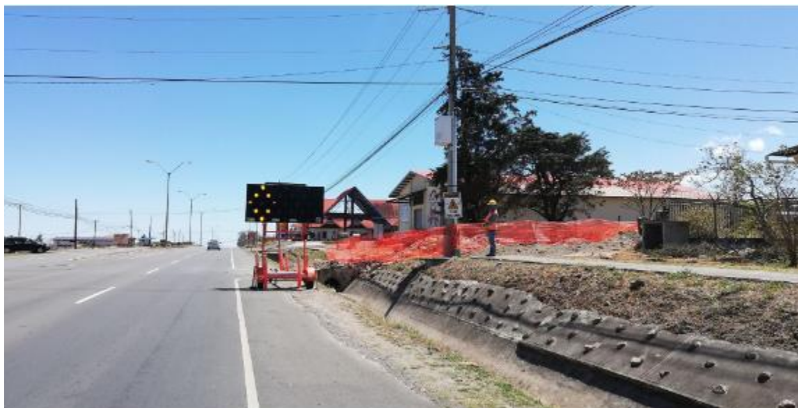
Fotografía 12. Señalización Vial en la Instalación de la línea de conducción hacia la PTAP -El Alto
