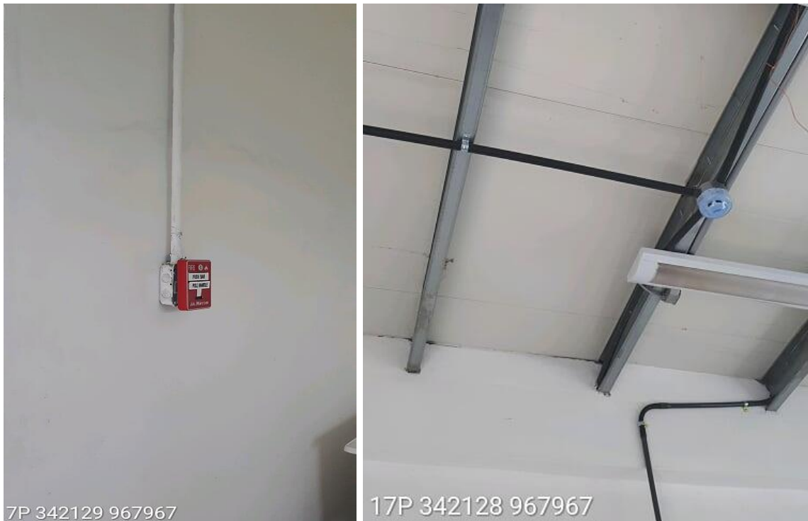
Fotografía 8. Alarmas contra incendios y detectores de humo
