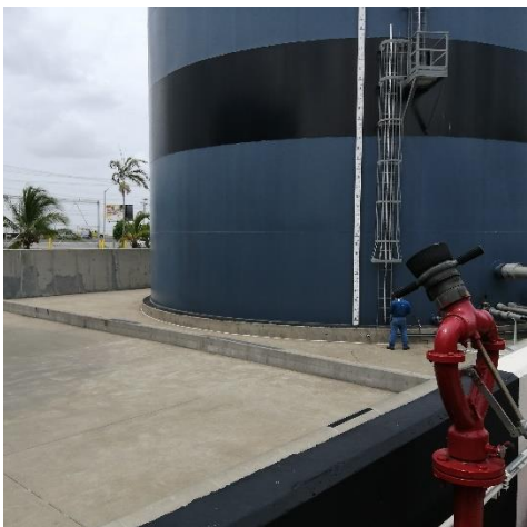
Fotografía No. 1: Tanques de almacenamiento de combustibles dentro de muros de contención.
