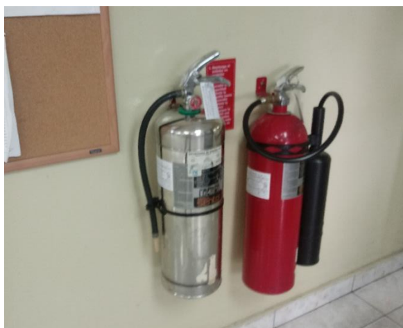
Fotografía No. 16: Extintores específicos para áreas especiales (cocina, comedor)
