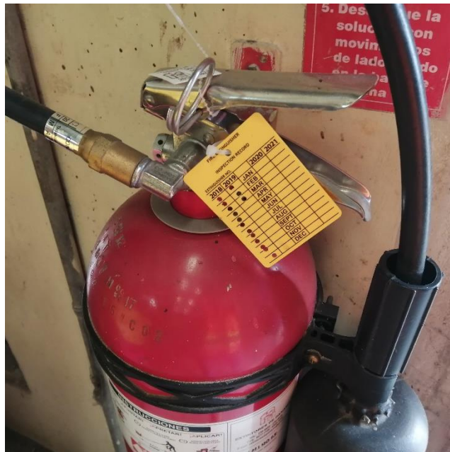
Fotografía No. 10: Tarjeta de inspección mensual de extintores, realizadas hasta el mes de julio:
