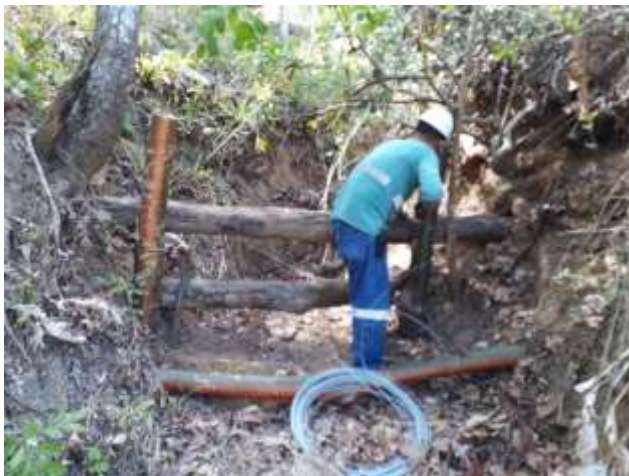
Fotografía No. 20: Mantenimiento de controles de erosión.
