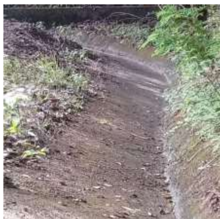
Fotografías No. 17-19: Mantenimiento y limpieza de cunetas.
