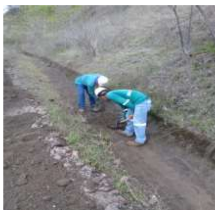
Fotografía No. 16: Limpieza de canales de sedimentación.
