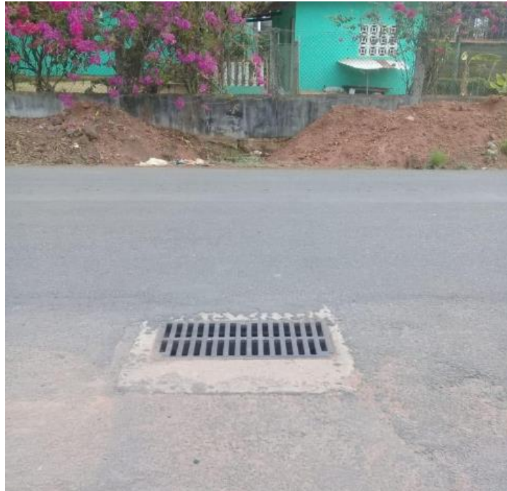
Parrilla de la tubería pluvial soterrada que cruza por la calle El Limite, donde va conducida soterradamente por tubería de PVC hasta la quebrada s/n.
