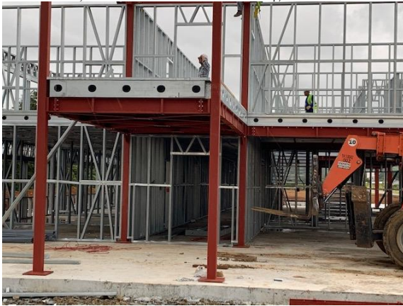
En la fotografía se puede apreciar que como las estructuras son prefabricadas, se realiza el proceso de armado.
