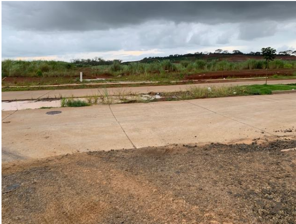
En la fotografía superior se observa la vía principal de la Urbanización La Hacienda, la cual da acceso al futuro colegio.
