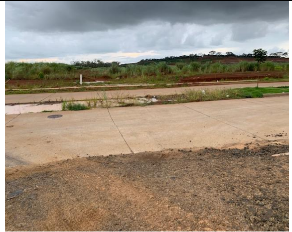
Foto 8-2. Frente al lote del proyecto encontramos la Avenida Circunvalación que es la vía por la cual se accesa a la urbanización.
