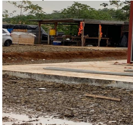
Se observa la oficina de campo presente en el lote del terreno de la futura escuela.
