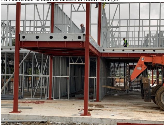
En la fotografía se puede apreciar que como las estructuras son prefabricadas, se realiza el proceso de armado.
