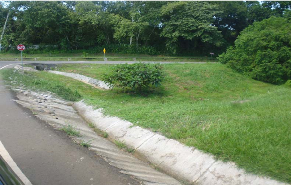
Imagen muestra las cunetas que convergen al cauce de drenaje para derivar las aguas a la quebrada Las Albercas.
