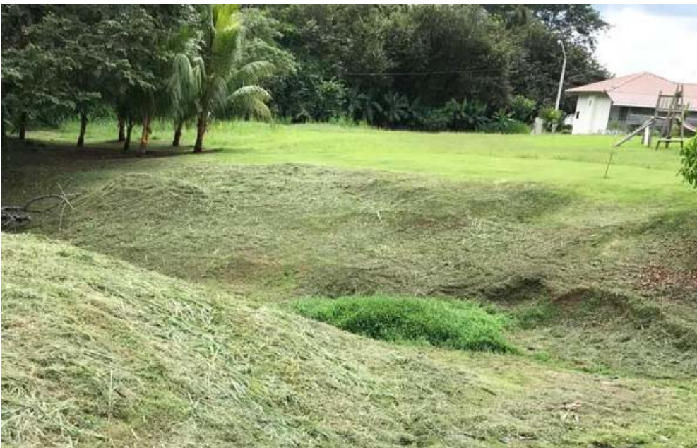
Imagen muestra el cauce de drenaje pluvial sobre el que se construye el drenaje francés
