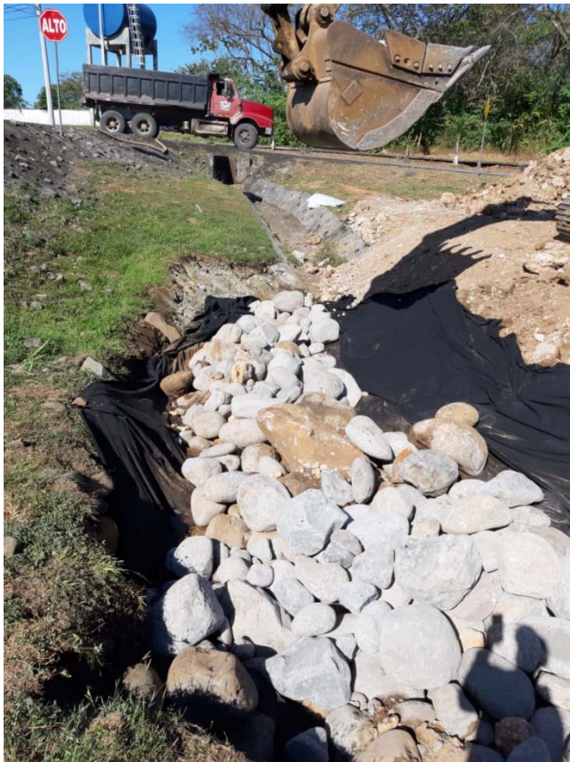
Inicio del subdrenaje en el cauce de drenaje de agua pluvial
