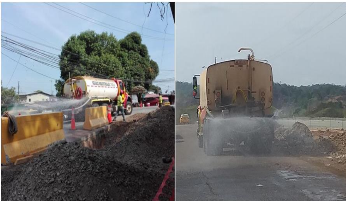
Fotografías 3 y 4. Para controlar el polvo en el proyecto y minimizar los efectos de las partículas, se riega con agua en un tanque cisterna.
