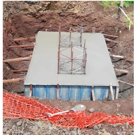
Colado y relleno de zapatas de pórticos.
