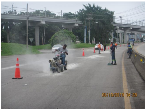
Trabajos de borrado de pintura.
