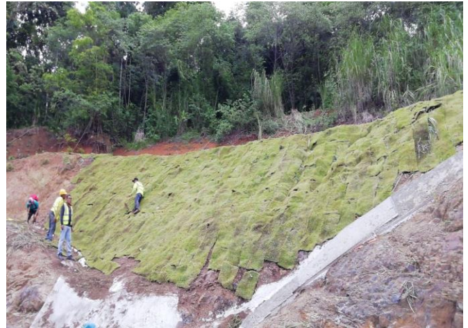
Colocación de grama en punto crítico 7K+800 del proyecto, como medidas permanentes para control de erosión.
