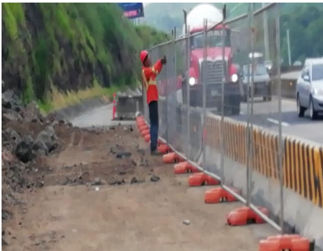
Colocación de mamparas como barrera de protección de escombros por los trabajos de conformación de talud. Estación 11K+300.
